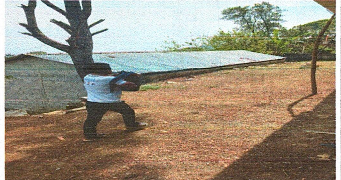
Foto 4: Sustitución de cubierta de lámina de metal.
